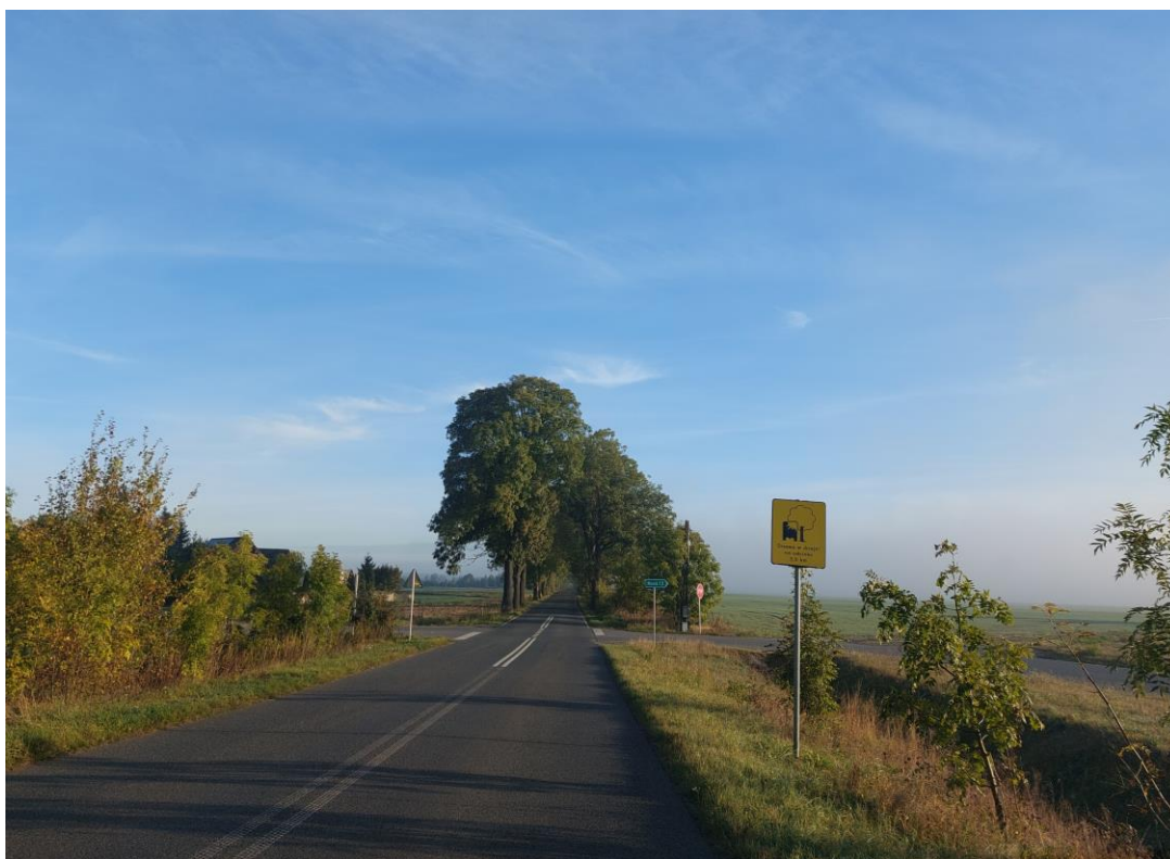
Fot. 10 Oznakowanie zawężonej skrajni drogi – droga powiatowa nr 1252C
