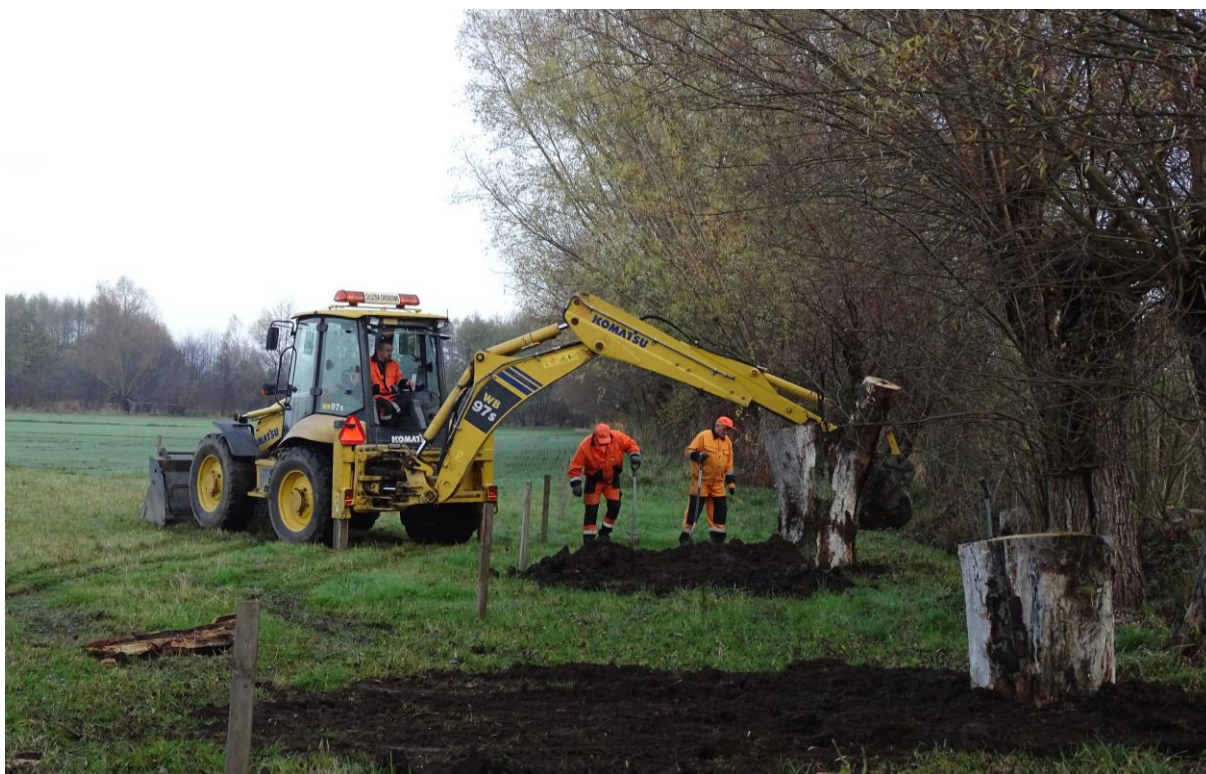
Fot. 5 Budowa „hotelu dla gatunków chronionych” tj. wkopanie pustych pni drzew jako nowych siedlisk dla gatunków chronionych w m. Chrystkowo
